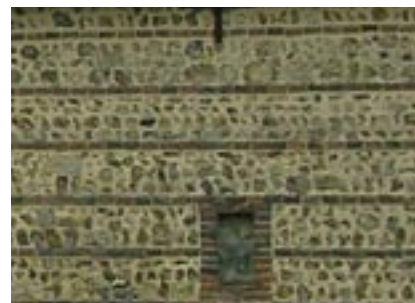
Assises irrégulières de silex cassés stabilisées par un rang de brique.
