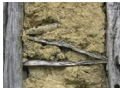
Torchis maintenu par des éclisses, petites lattes de bois fixées en quinconce
