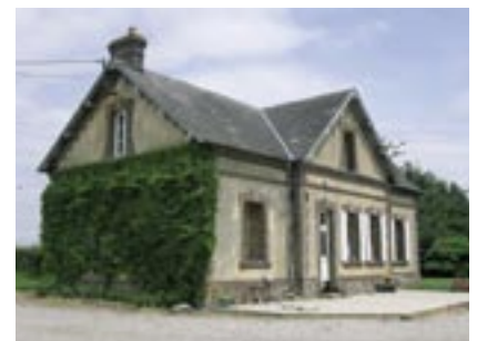
Toit à deux versants avec un fronton de pignon sur la façade principale d'une maison rurale du XIX e siècle
