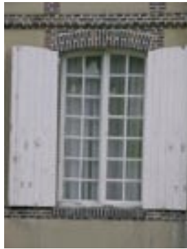
Volets pleins : assemblage à lames
