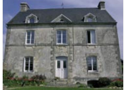
En limite du Perche et de la plaine d'Argentan, les constructions sont réalisées en moellons de calcaire, pierre tendre et gélive et pierre de taille pour les encadrements de baies et chaînes d'angle.
