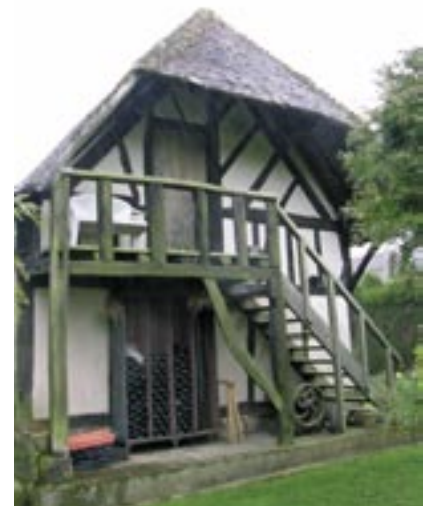
Aux confins du Pays d'Auge (Monnai et Heugon) « queue de geai » ou demi croupe débordante formant avant-toit pour abriter l'escalier d'accès aux combles.
